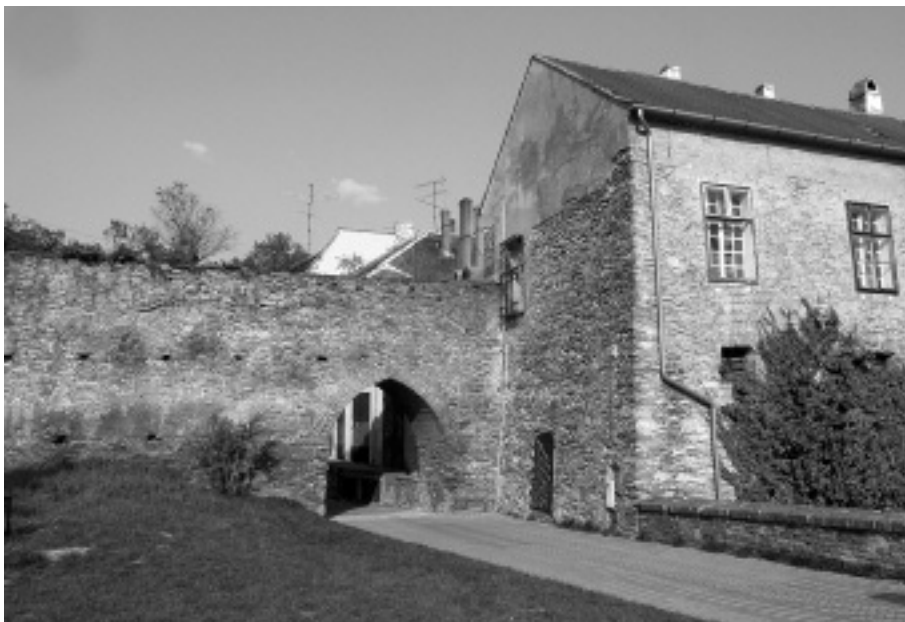
Az egykori falszoros helyén, annak vár felőli végén 1803-ban emelt épületszárny a városárok és a Diáksétány sarkán. Fotó: B. Benkhard Lilla, 2006
