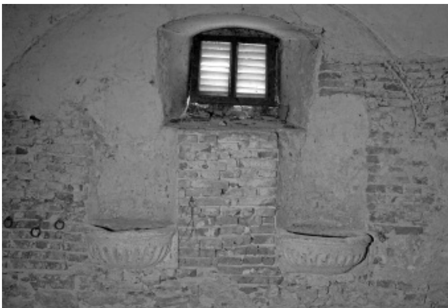
A nyugati oldalon észak felé kiugró, új épületszárnyban elhelyezett istálló, kőből faragott itató medencékkel. Fotó: Malustyik Mariann, 2015
