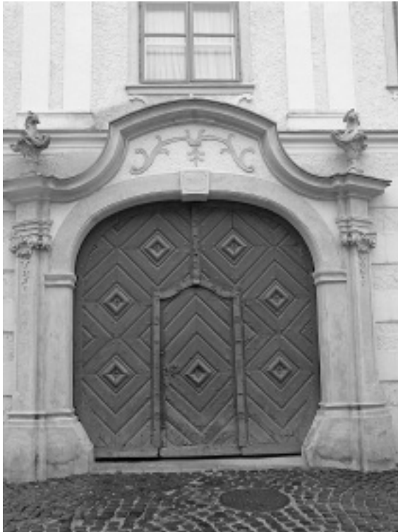
A Chernel utcai főhomlokzat barokk kapuzata, zárókövén 1766-os évszámmal. Fotó: B. Benkhard Lilla, 2015
