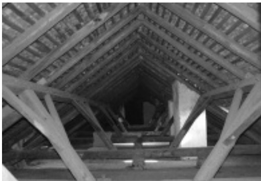
Barokk formájú, ún. dült székes tetőszerkezet 1880-ból az északi szárny fölött. Fotó: B. Benkhard Lilla, 2015
